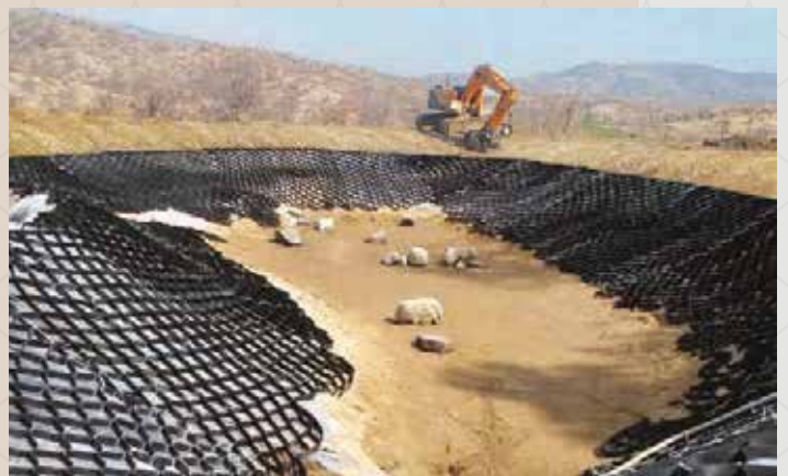
Geocell Geomembrane Protection Layer
